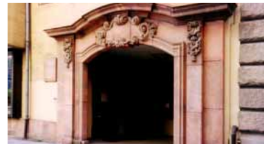
Eingangsportal des ehemaligen Hotel de Saxe
