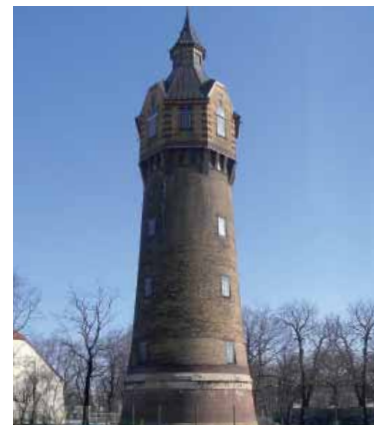
Weithin sichtbares Wahrzeichen: der Wasserturm
